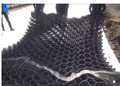
4. ジオセル敷設1
