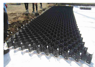
ジオセル敷設2
