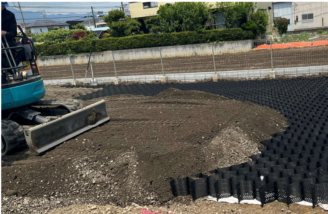
写真 1 「ecowebジオセル」の駐車場における施工事例
