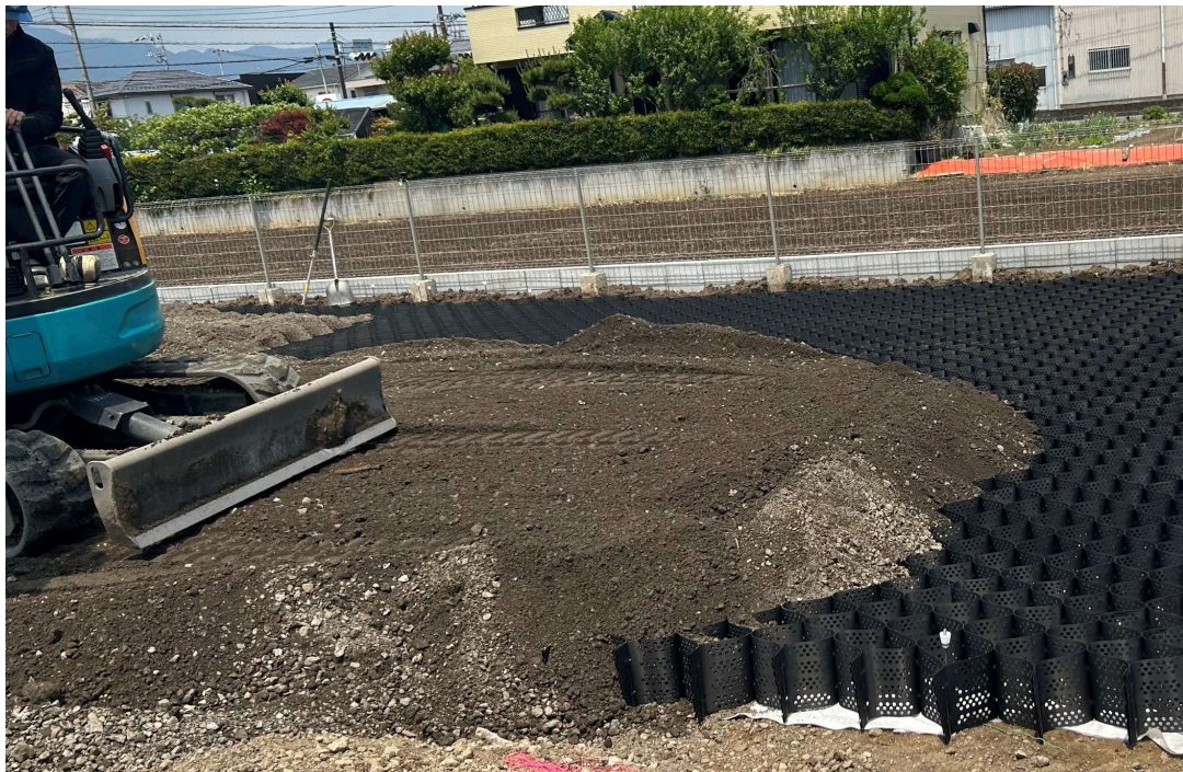
写真-1 施工事例
